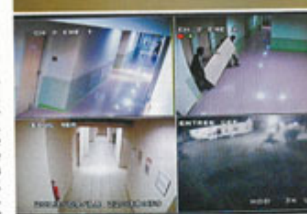
CEIL VIGILANT Les 12 chambres individuelles sont au même étage que la salle de contrôle du gardien de nuit, où sont installés ses quatre écrans de surveillance.
