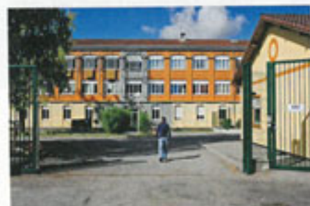
PROJET PÉDAGOGIQUE Le Sysstion (CEF), installé dans un ancien bâtiment du 151 e régiment d'infanterie, a été conçu pour répondre aux exigences de l'accueil et de la garde de jeunes délinquants.
