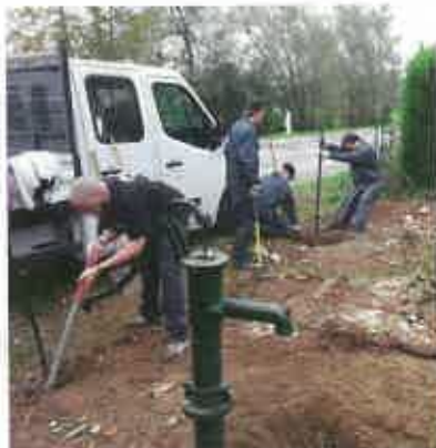
Un chantier porté par l'AMSEAA.
